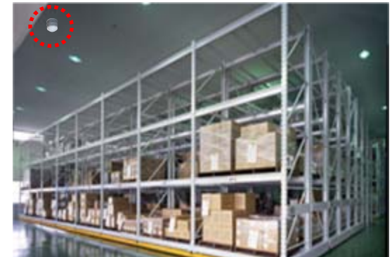
貸倉庫の省エネ照明制御などに...
