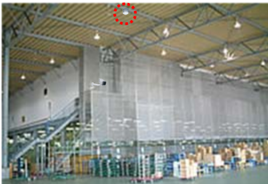
夜間の照明制御・侵入監視などに...
