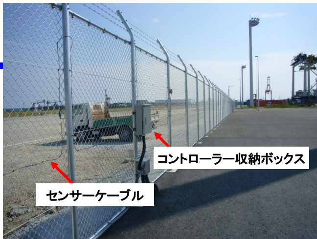
▲国際コンテナターミナル
